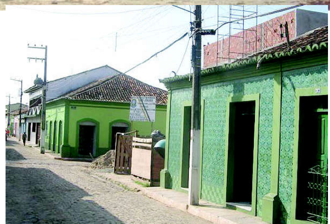
Foto maior: Vista lateral do Fórum em construção. Foto menor: esquina da Rua Prof. Antônio Lopes entre a Farmácia Sereje e o antigo Cartório do Sr. Ozias Mendonça, onde ficará situada a destoante sede do Fórum
