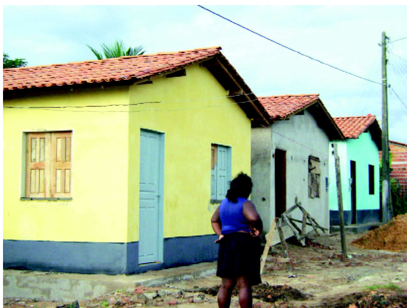
Casas populares em fase de acabamento no bairro da Piçarreira.
