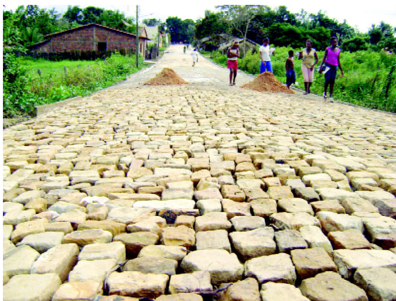
Rua sendo calçada na Vila Zizi.
