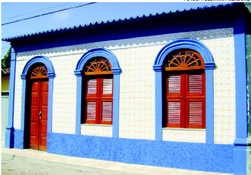
O prédio de nº 183 da Rua Antônio Lopes com sua fachada recuperada
