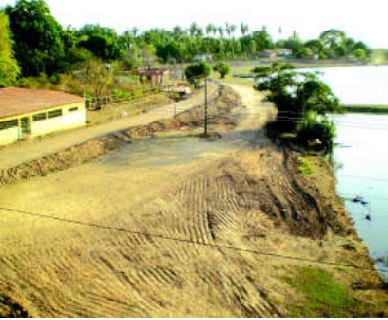
Retirada criminosa de areia do leito do lago e construções de barragens temporárias aceleram o processo de assoreamento
