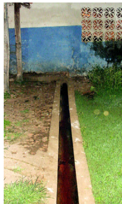
Canaleta por onde escorrem, para o ambiente externo, os resíduos líquidos dos animais abatidos
