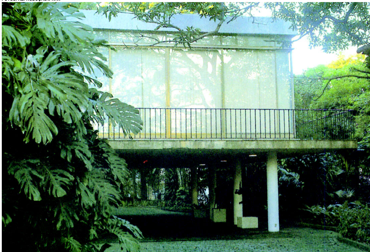
Museu Chácara do Céu: situada no bairro carioca de Santa Teresa, a casa era a antiga residência de Raimundo Castro Maya e família
