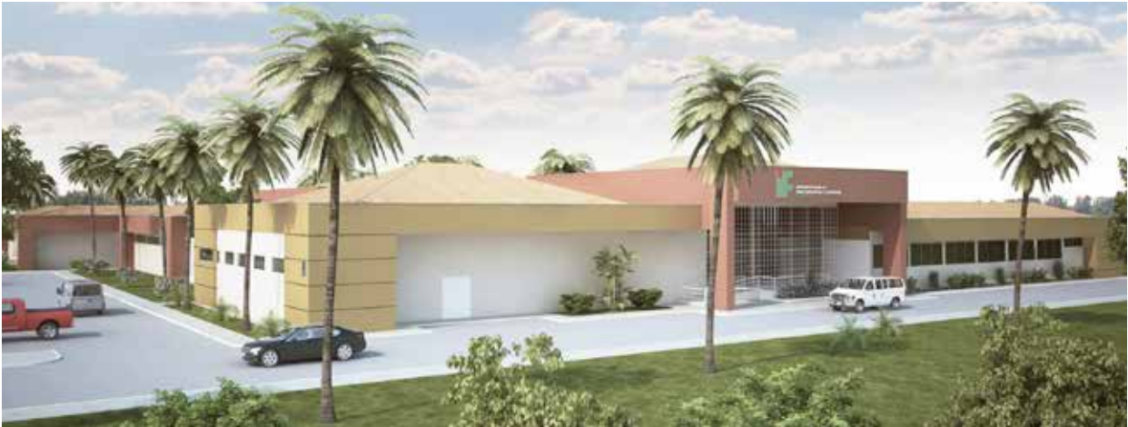
Maquete do prédio do IFMA (em construção)
