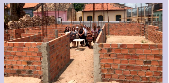
1ª etapa da construção da Sede da AVL
