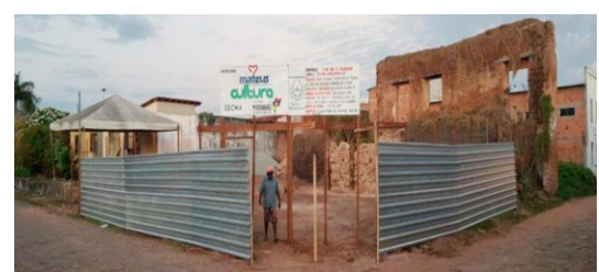
Local onde está sendo construída a Sede da AVL
