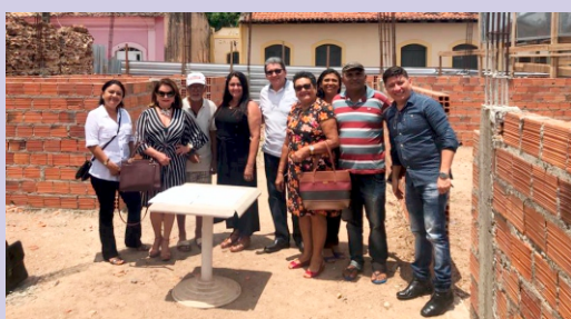
Acadêmicos da AVL recebendo a 1ª etapa da construção concluída
